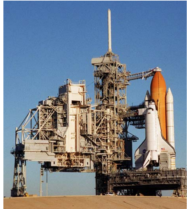
Il Rotating Service Structure dopo il rollback in posizione di sosta prima del lancio della missione STS-97 dello Shuttle. (Immagine: NASA)
