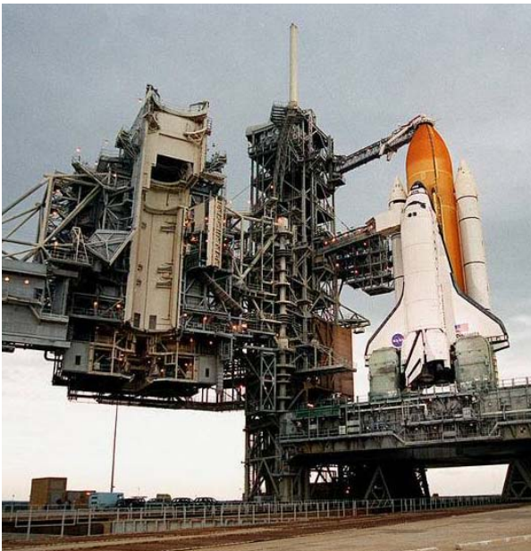
Rymdfärjan Discovery på startplattan den 16 december 1999 före starten av STS-103, ett serviceuppdrag för Hubbleteleskopet, med ESA-astronauterna Claude Nicollier och Jean-Francois Clervoy. Den roterande servicestrukturen (till vänster) visas tillbakarullad. (Bild: NASA)
