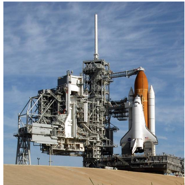
Den roterande servicestrukturen efter att den dragits tillbaka till uppställningspositionen före starten av uppdrag STS-123 den 10 mars 2008. (Bild: NASA)
